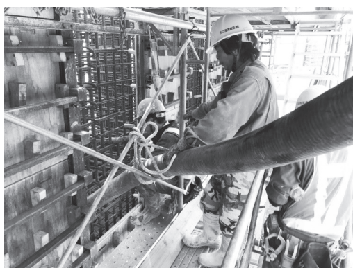
写真—2 コンクリート打設状況 (圧送ホースの水平挿入)
