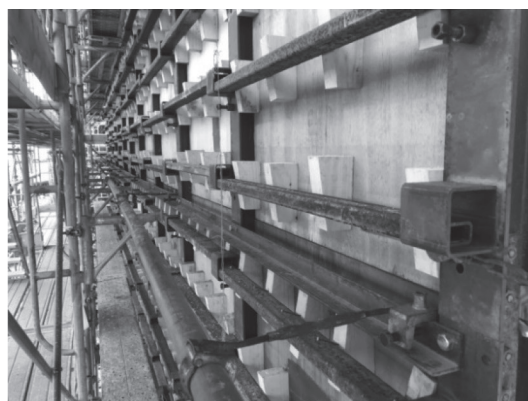
写真—1 本工法 型枠構造
